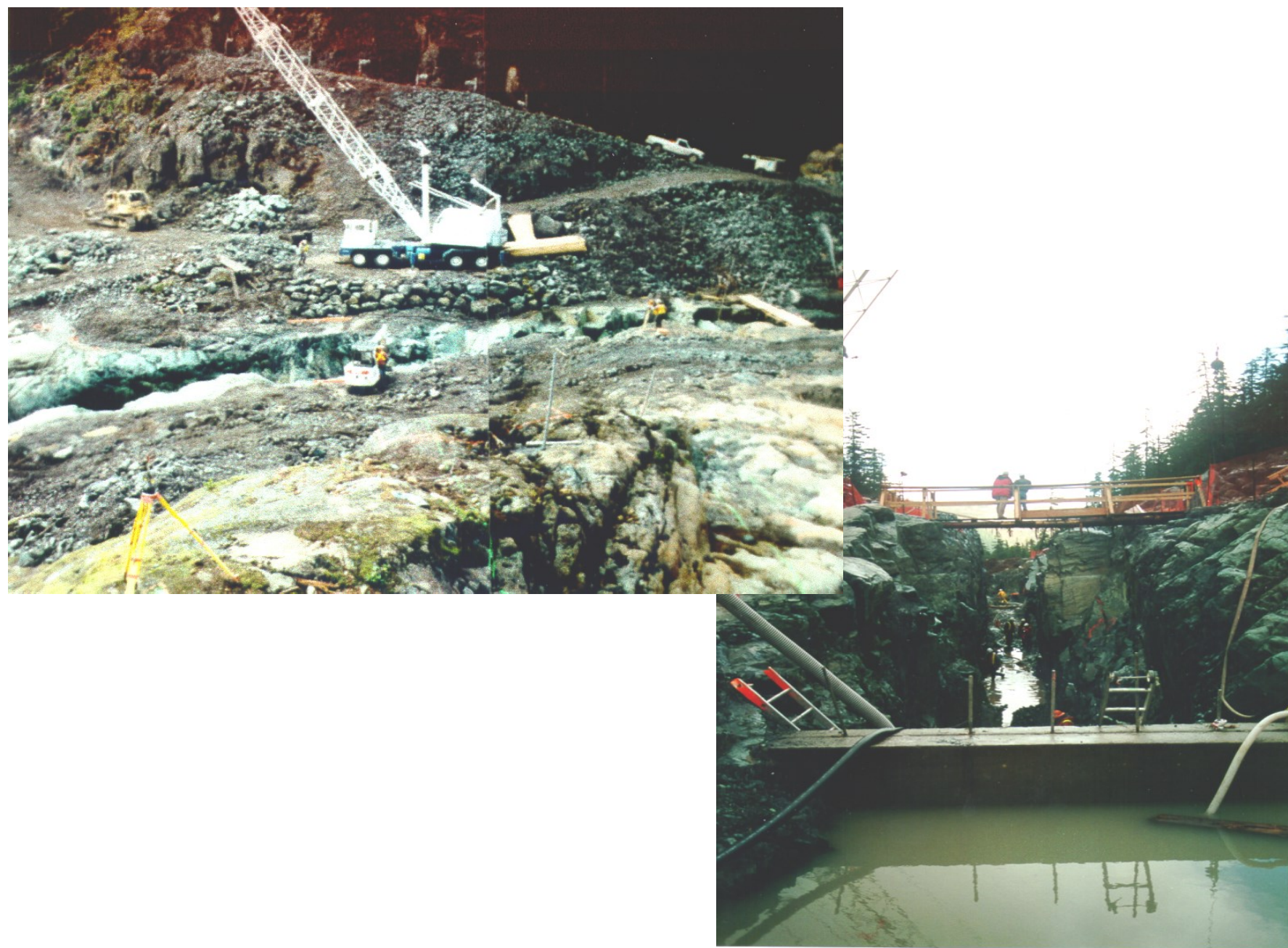
Arrowsmith Dam Construction 1998—1999
